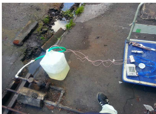
fig1.TLV製スチームトラップ実験状況
