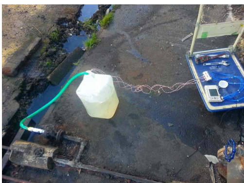
fig2.ピンチスチームトラップ実験状況
